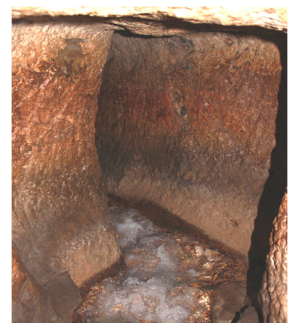
Hiskias tunnel från Gihonkällan till Siloa-dammen högs ut för vattenförsörjning inför Assyriens invasion 701 f.Kr. (2Kon 20:20).
