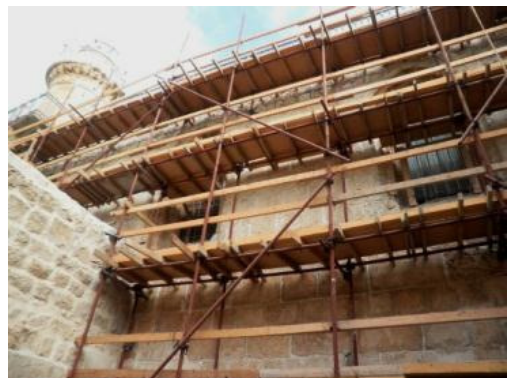
Restaurering av fasad
