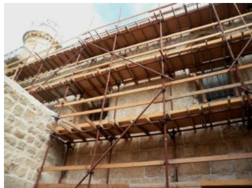
Restaurering av fasad
